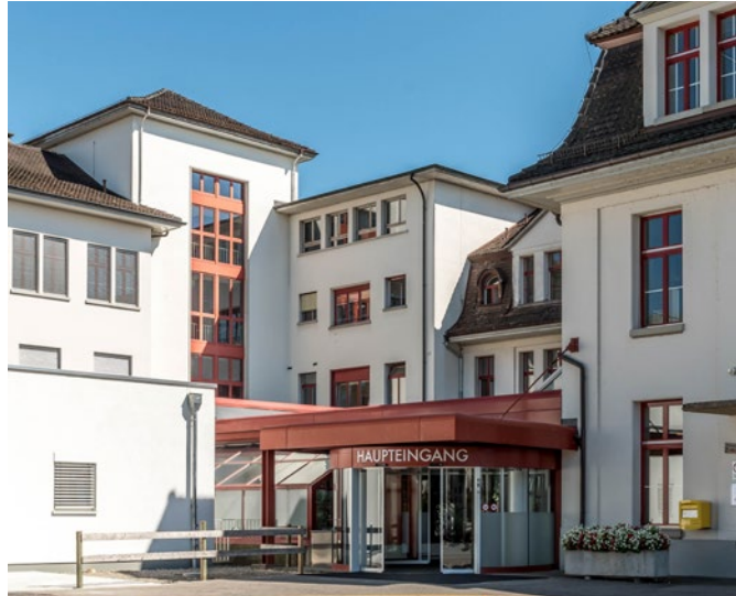
Das Spital Tiefenau setzt auf erneuerbare Energien.
